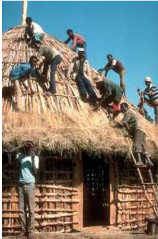
Foto Archivio Missioni Braccia al lavoro per costruire una grande capanna
