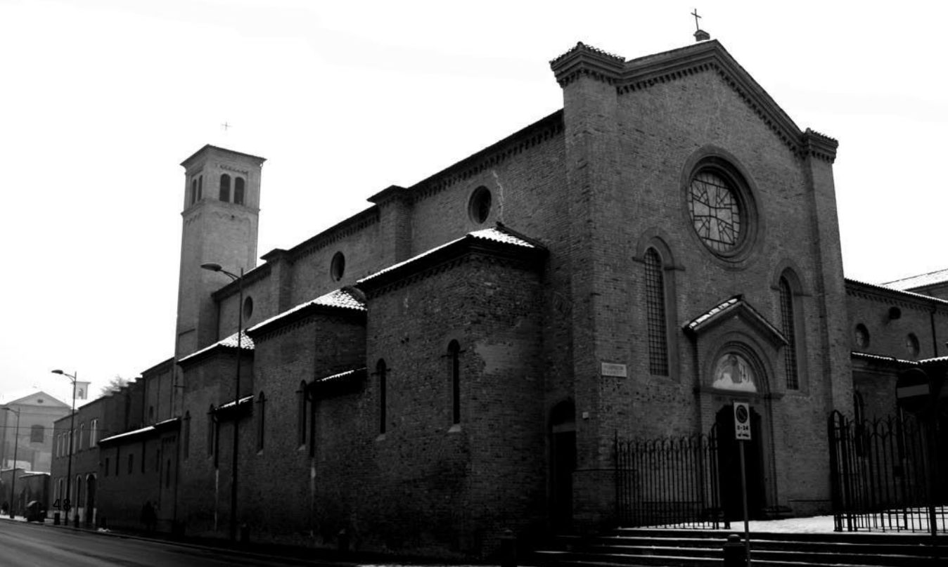
Facciata della chiesa dei cappuccini di Piacenza
