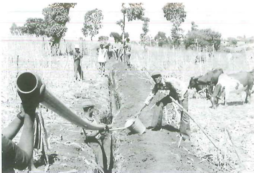
La posa dei tubi dell'acquedotto
