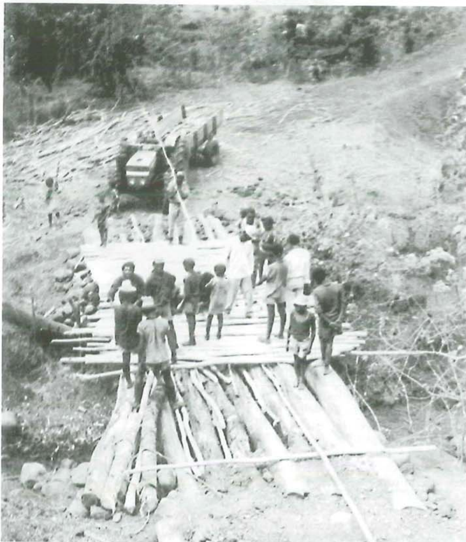
La costruzione di un ponte a Timbaro nel 1973
