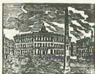
ROMA - PALAZZO DI MONTECITORIO
