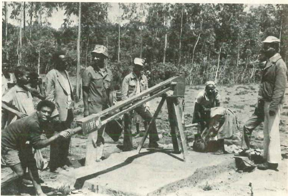
Un pozzo costruito presso Taza
