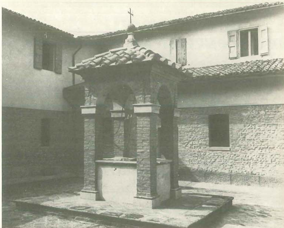
Il chiostro del convento di Castel S. Pietro, Centro provinciale del T.O.F.
